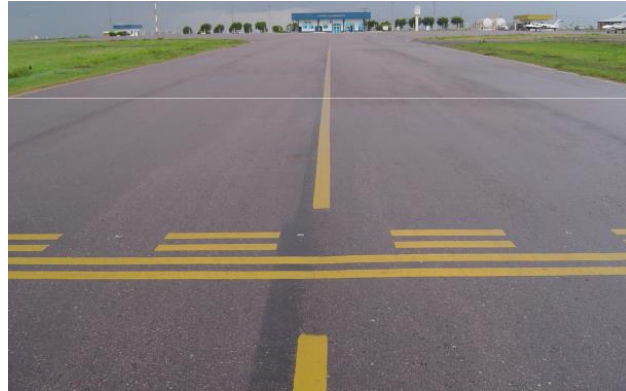
Figura 12 - Sinalização de ponto de espera (ANAC, ABETAR, 2010)
